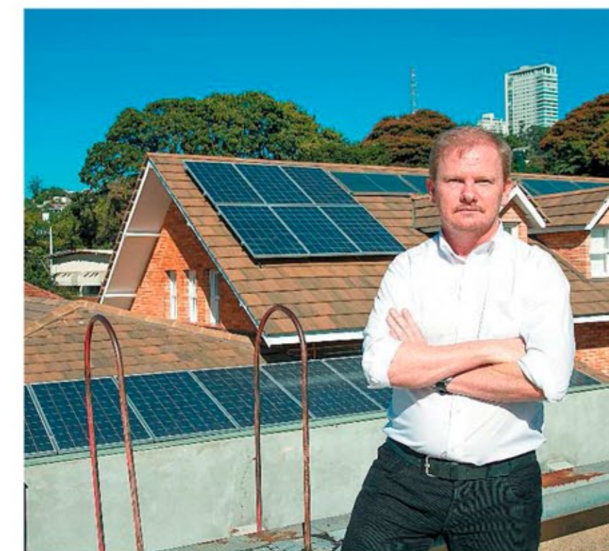
Placas fotovoltaicas foram instaladas na residência dos padres jesuítas do Colégio Loyola, no bairro Cidade Jardim: “É importante ter consciência ecológica”, diz o padre Germano Neto, diretor da escola
